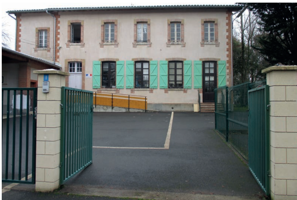
Une nouvelle rampe d'accès
